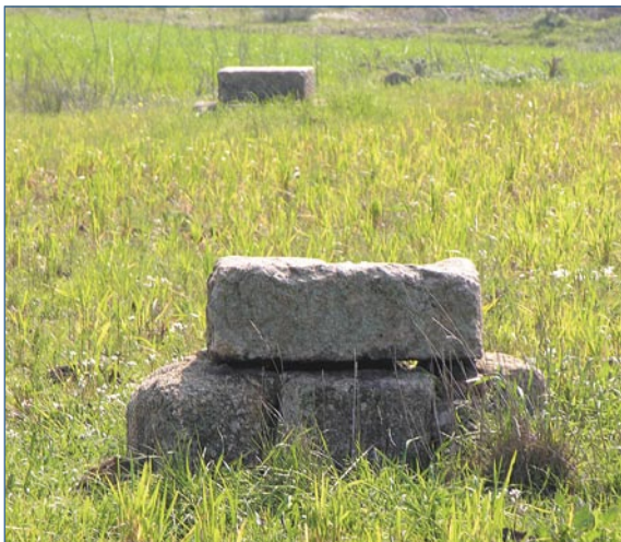
Registros equidistantes del acueducto con cubiertas monolíticas.
