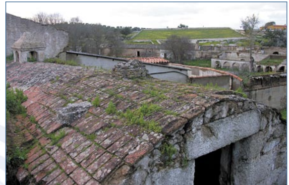
Lavadero de lanas. En primer plano los restos de un molino harinero accionado con el agua del embalse, al fondo la explanada inclinada para tender y secar la lana.
