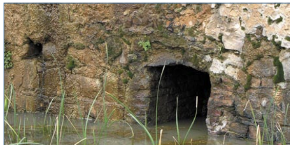
Solución puntual para que desagüe del terreno sin afectar a la fábrica del acueducto (repararse en las huellas del encofrado).
