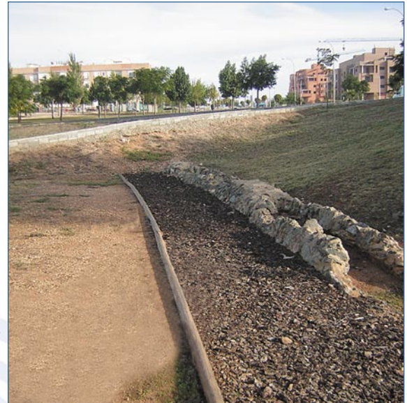
La conducción sigue las curvas de nivel.
