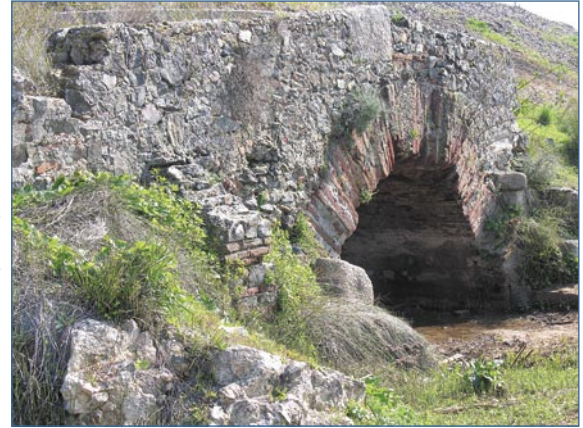
Puente de la Alcantarilla aguas abajo.
