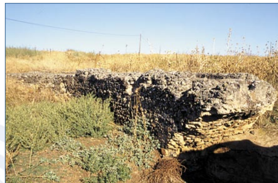
Cuando hay depresiones en el terreno se salvan construyendo muros y arquerías.
