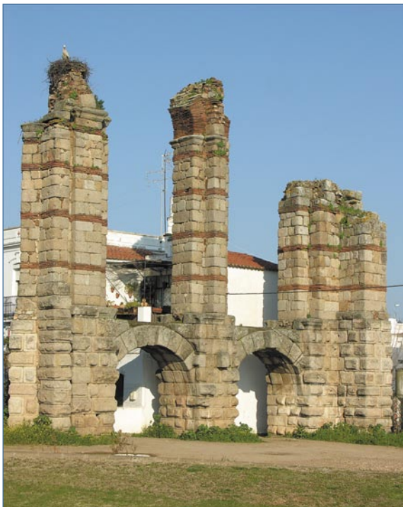
Parte conservada de los pilares del acueducto romano de San Lázaro.
