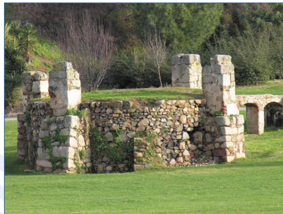
Parte superior de una noria, con pilares para una techumbre.
