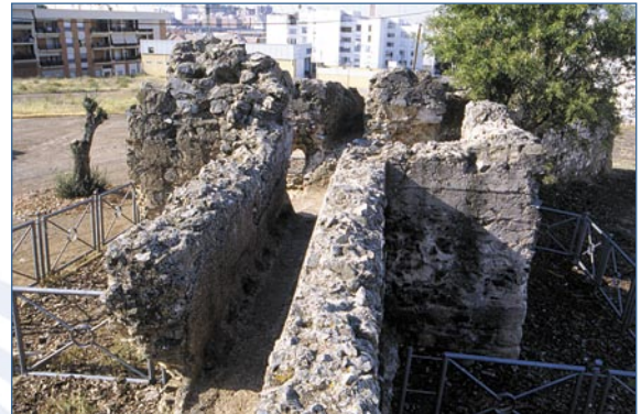
Canal del acueducto y piscina para decantación
