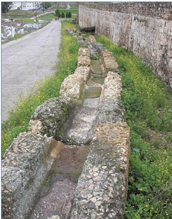
Fábrica romana con los morteros de impermeabilización.
